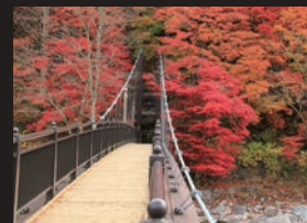
Kurenai Suspension Bridge 紅の吊橋
