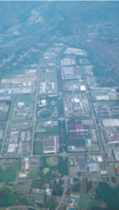
Complexe industriel de Kiyohara (Utsunomiya) 清原工業団地（宇都宮市）
